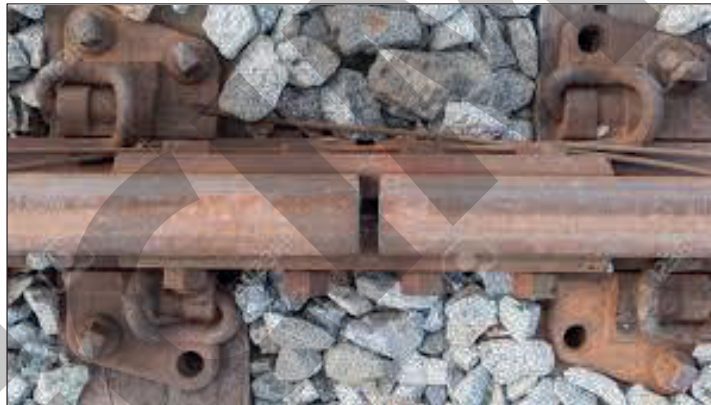
Document 5 : Joint de dilatation (portion de rail)
