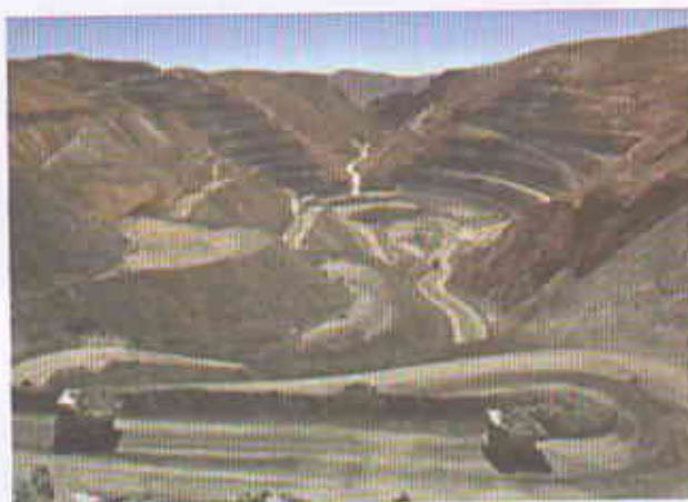
EXPLOITATION À CIEL OUVERT
