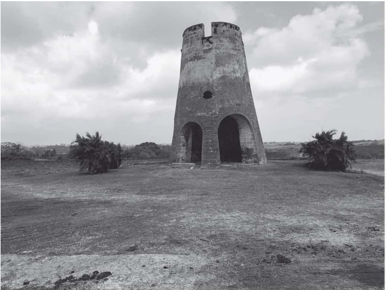
Fig. 19 : Ruines de la chaudière, plantation de Drax, Saint George, la Barbade. ¶ (Photographie Howard W. French)
